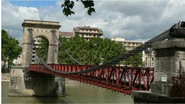
La passerelle Masaryk délimite au sud le bassin de la Caille. C'est un pont suspendu qui a été financé par les riverains, et a été inauguré le 17 mai 1831. Il est composé de 2 travées, mesure 85,20 m et possède un tablier de 6,50 m pouvant supporter 2,5 tonnes.
